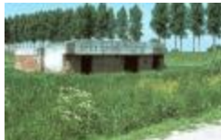
Bunker in de Fortstraat, Doel (PCPP20110912014)
