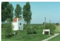
Bunker in de Fortstraat, Doel (PCPP20110912015)
