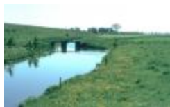
Watergang onder de scheldedijk (PCPP20110912006)
