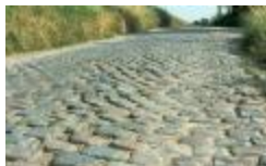
Bestrating van de Fortstraat (PCPP20110919001)
