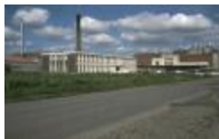
Melkfabriek Milcobel in de Fabriekstraat te Kallo (PCJM20120829- _001)
