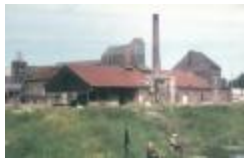
Suikerfabriek aan de Melkaderbrug - gesloopt in 1972 (PCJM20120828_008)
