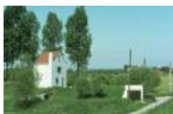
Bunker in de Fortstraat, Doel (PCPP20110912015)
