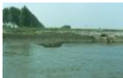
Frans dijkje en verlaatsluis (PCPP20110919003)
