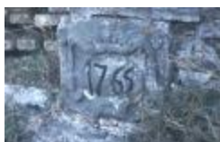
Sluitsteen van de duiker onder de Verkortingsdijk in Doel (PCJM20120902_013)
