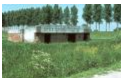
Bunker in de Fortstraat, Doel (PCPP20110912014)
