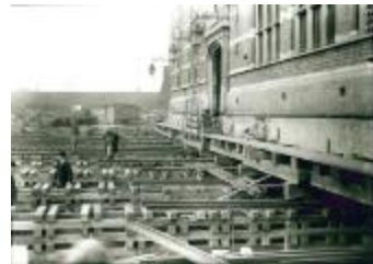
Verplaatsing Dam Statie 3 (GZ Tul208)
