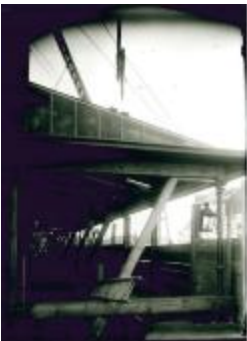
Verplaatsing Dam Statie (GZ Tul206)
