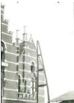
Verplaatsing Dam Statie 6 (GZ Tul211)
