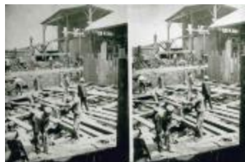
Verplaatsing Dam Statie 7 (GZ Tul212)
