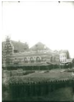
Verplaatsing Dam Statie 2 (GZ Tul207)
